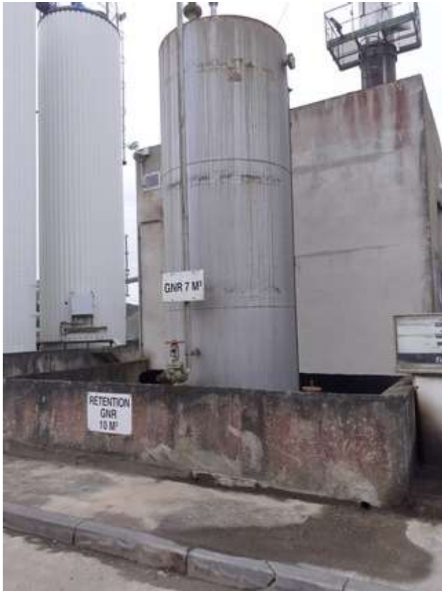
Silo vertical de GNR avec sa rétention adaptée
