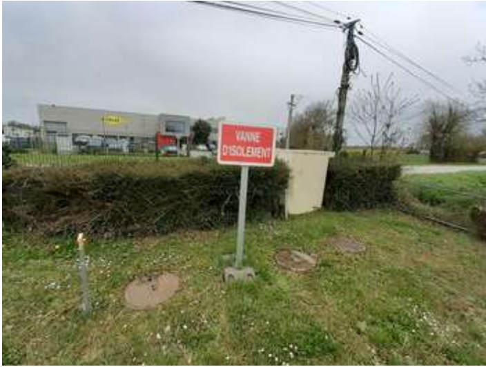
Vanne d'isolement permettant de confiner les eaux polluées
